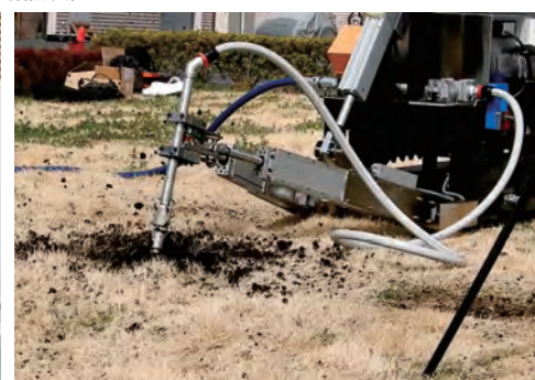
圧縮空気ですり取り飛ばして掘削します
